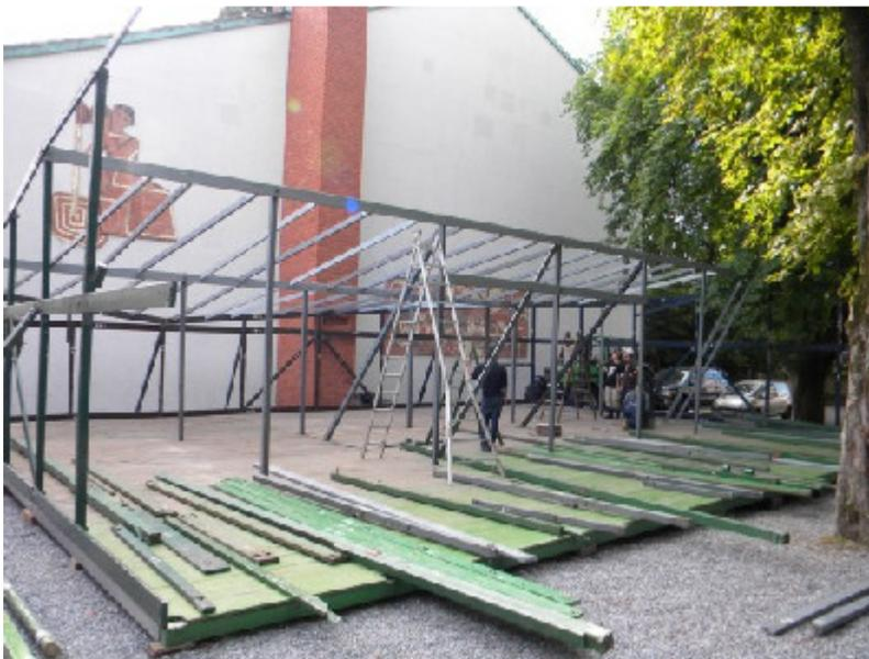
Aufbau des Trägergerüsts für die Seitenwände, den 1. Stock und das Dach.
